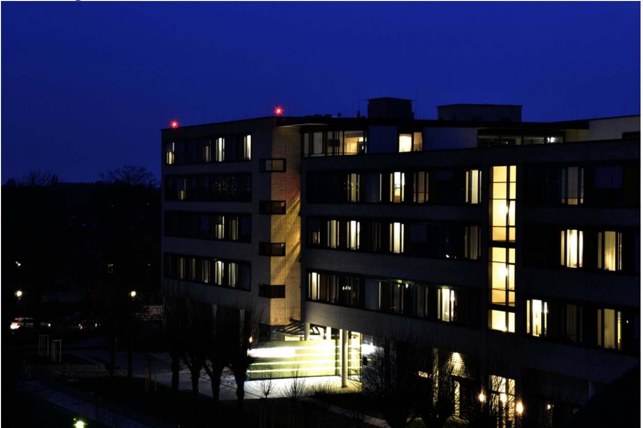
Abbildung: Außenansicht Neues Bettenhaus bei Nacht
